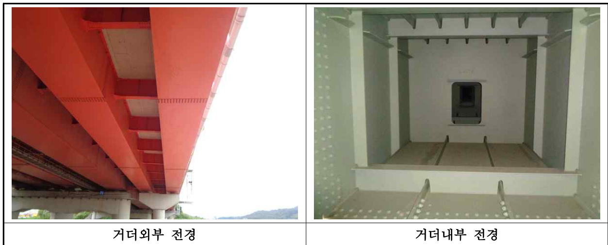
【사진 1.3.4】 거더 전경
