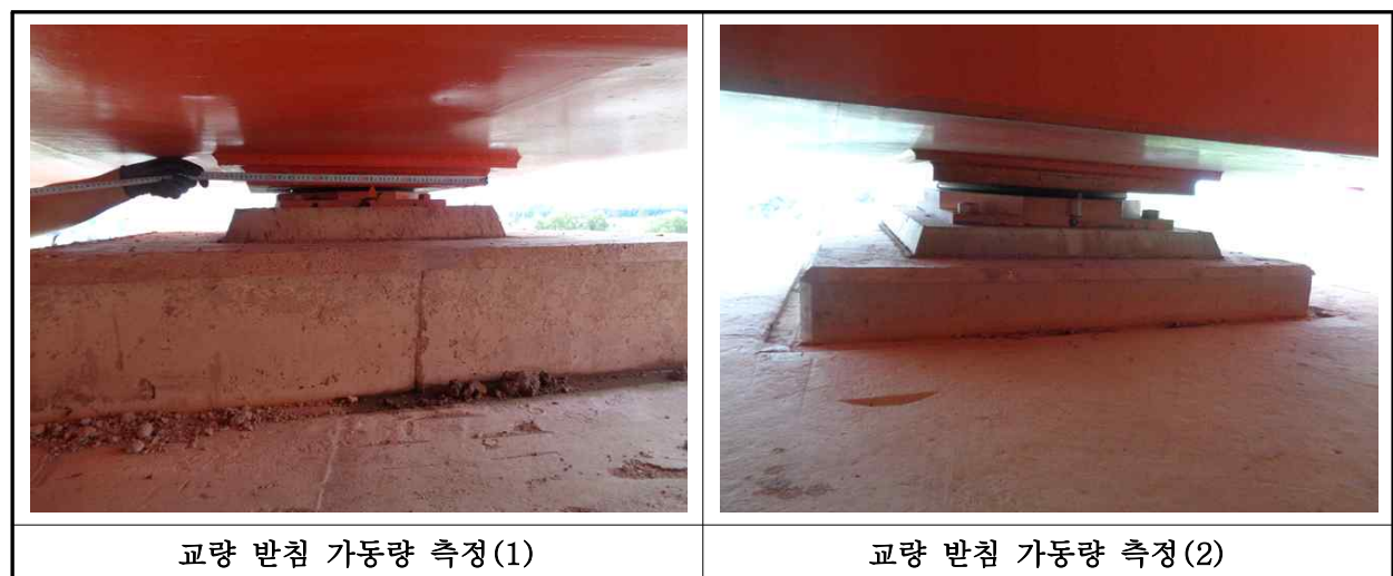
【사진 1.3.15】 교량받침 이동량 측정
