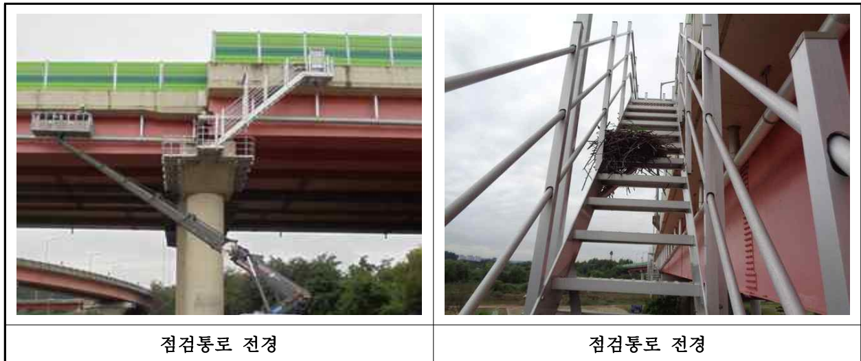
【사진 1.3.25】 교량 점검시설 전경
