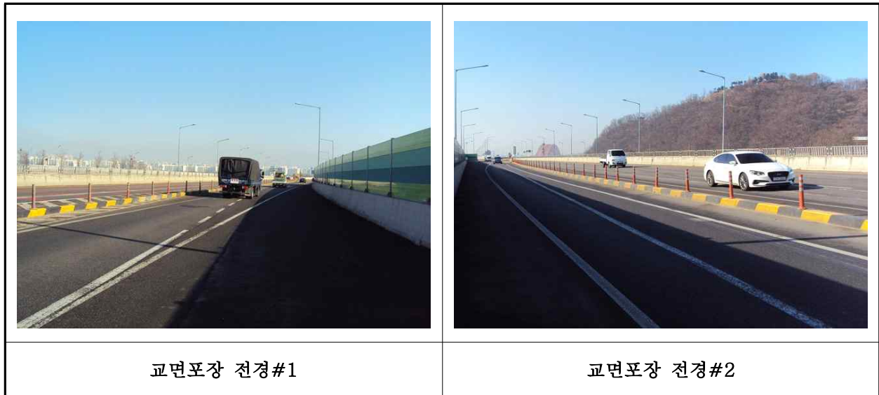
【사진 1.3.19】 교면포장 전경
