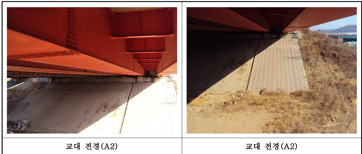
【사진 1.3.8】 교대 전경
