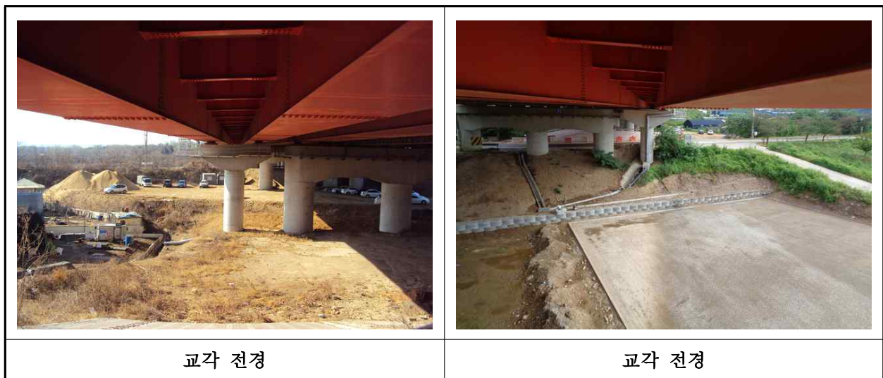
【사진 1.3.10】 교각 전경
