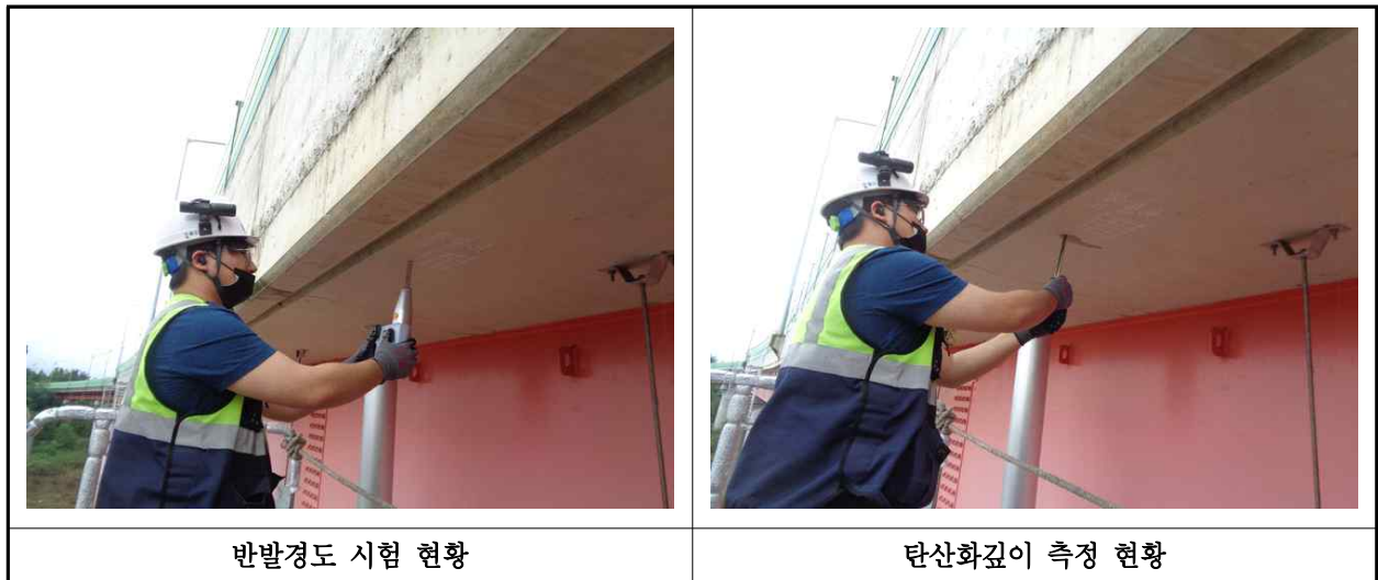
【사진 1.4.1】 콘크리트 내구성조사 현황
