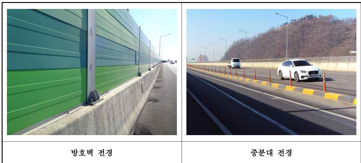
【사진 1.3.23】 방호벽 및 중앙분리대 전경
