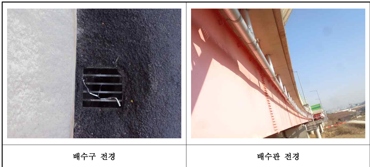
【사진 1.3.21】 배수시설 전경
